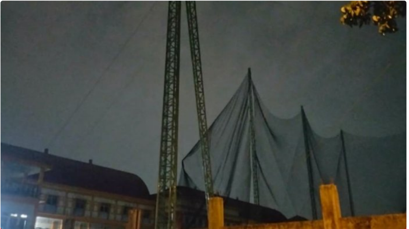
Tiang bangunan lapangan golf mini yang berada di Jalan Pancing, Kelurahan Indra Kasih yang tumbang, Kamis (10/11)
